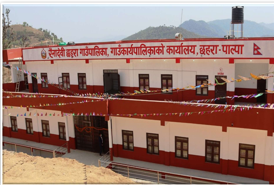
रैनादेवी छहरा गाउँपालिकाको प्रशासकीय भवन
